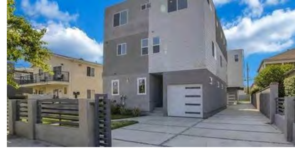
12 2301 Hauser Blvd 2301 Hauser Blvd Los Angeles, CA 90016
