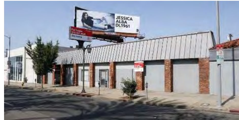
3 1233 N Highland Ave 1233 N Highland Ave Los Angeles, CA 90038
