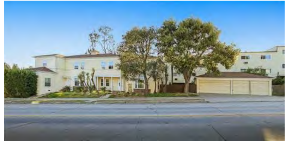
1 3205 Griffith Park Blvd Los Angeles, CA 90027
